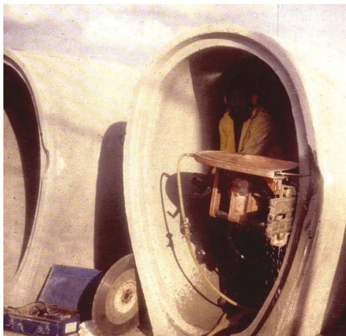
**Sciage d'un piédroit pour "l'essai Créteil"**
