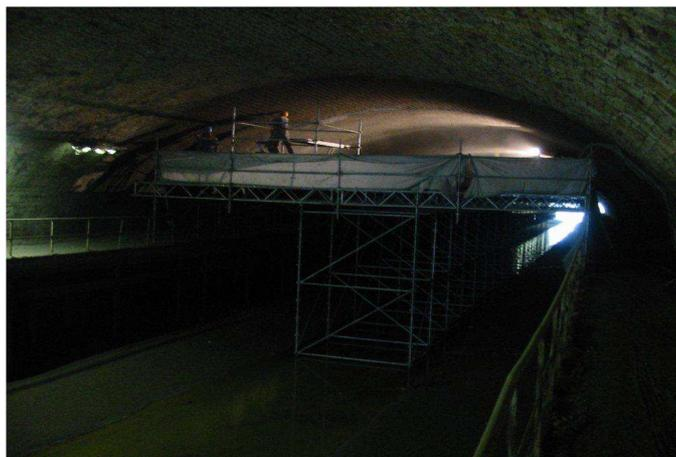
Le chantier s'est déroulé sur 7 semaines. 1160 m<sup>2</sup> de traitement de voûte ont été réalisés ; le béton a été mis en œuvre avec une machine LANCY type Tubaflow.
