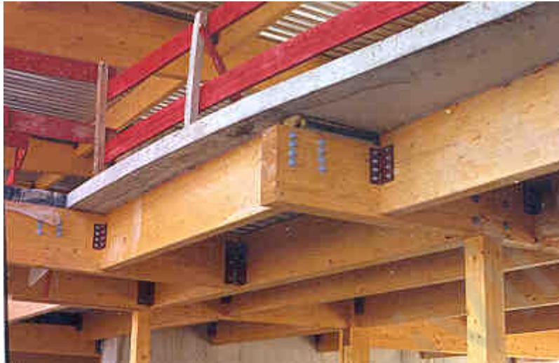
Plancher constitué d'une dalle de béton liée mécaniquement par des organes de connexion à des poutres en bois.
