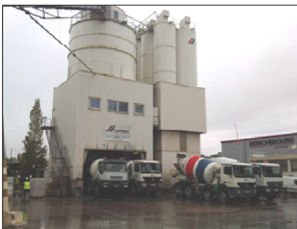
Centrale à béton
