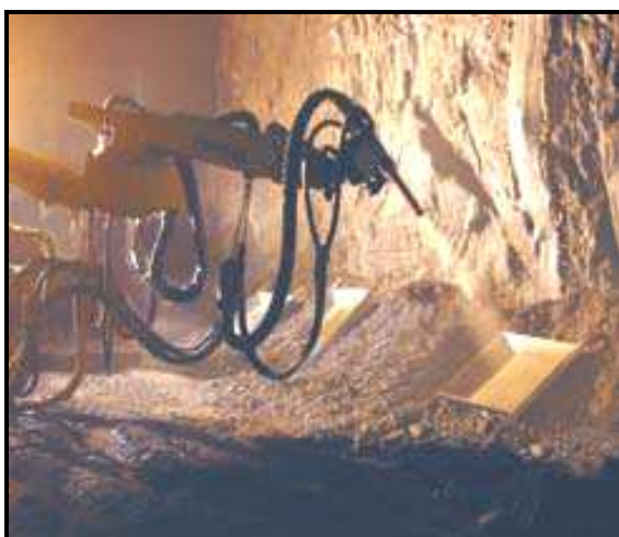
Projection robotisée dans une caisse d'essai
