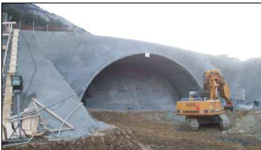
Exemple de béton projeté fibré en tête de tunnel
