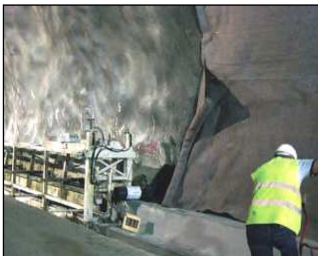
Pose d'un géotextile renforcé sur béton projeté fibré
