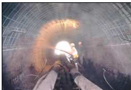
Exemples de projection de béton sur treillis soudé
