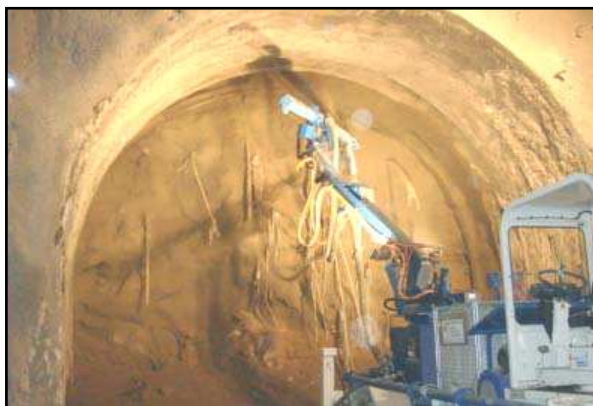
Projection robotisée de béton fibré en front de taille
