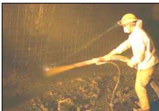
Exemples de projection de béton sur treillis soudé
